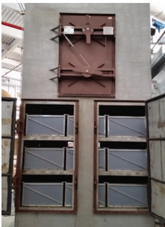
Installazione GMCS Stand-alone dopo un assorbitore in un impianto di incenerimento fanghi
